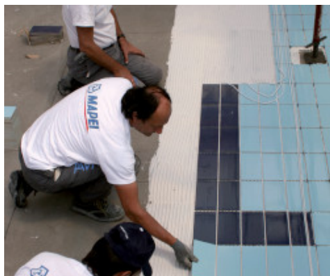
Montarea placilor ceramice Mapelastic Zero intr-o piscina
