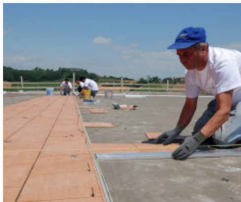
Montarea placilor ceramice cu Kerabond TR + Isolastic
