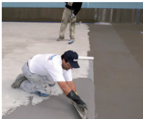
Hidroizolarea unei piscine cu Mapelastic Zero
