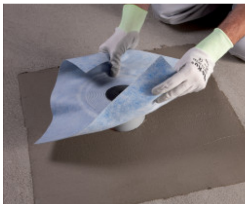
Aplicarea Drain Vertical pe Mapelastic Zero
