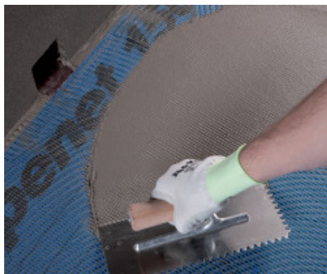
Aplicarea Mapelastic Zero pe Mapenet 150
