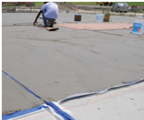
Hidroizolarea sapelor cu Mapelastic Zero si Mapeband
