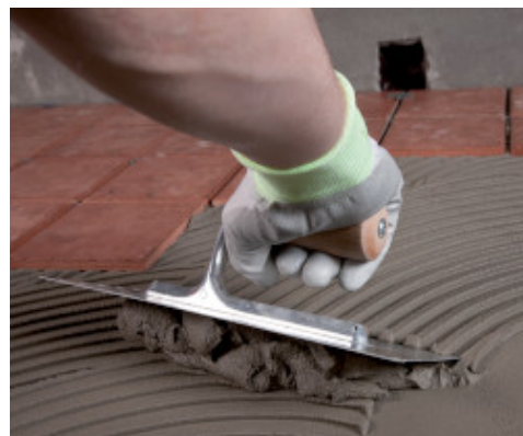
Aplicare Granirapid pe o terasa hidroizolata cu Mapelastic Zero
